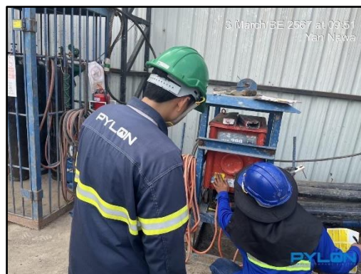
รูปที่ 55 เจ้าหน้าที่ตรวจสอบสายไฟ อุปกรณ์ไฟฟ้าต่างๆ ให้อยู่ในสภาพพร้อมใช้งานเสมอ
