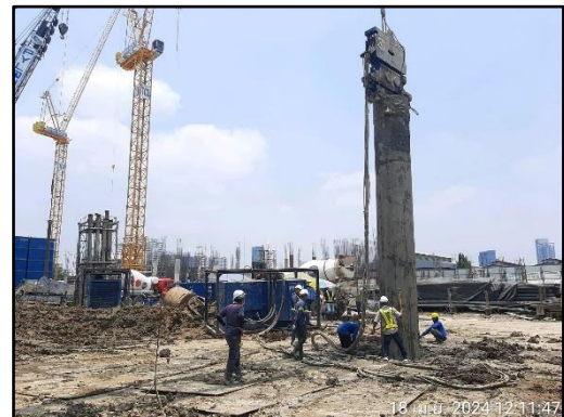
รูปที่ 25 ก่อสร้างฐานรากโดยใช้เสาเข็มเจาะ (Caisson Drilling)
