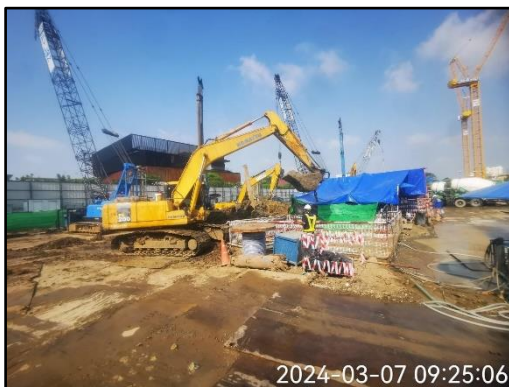
รูปที่ 39 ขุดลอกตะกอนที่สะสมในบ่อดักขยะและดักตะกอนดิน
